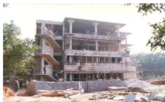
Рис.4. Четырехэтажное здание ИИТ Дели, построенное с использованием зольных кирпичей
