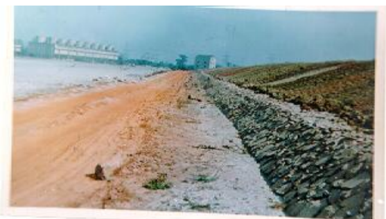
Рис.10. Дамба, построенная с использованием летучей золы, на ТЭС Корба, Мадья-Прадеш
