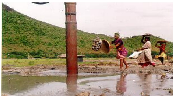
Рис.11. Уплотнение гидрозолоотвала ТЭС Виджейвада с помощью виброфлотации, Андхра-Прадеш
