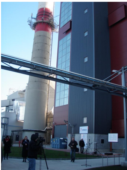
Рис. 1. Электростанция в Щецине с системой сжигания биомассы в кипящем слое.
