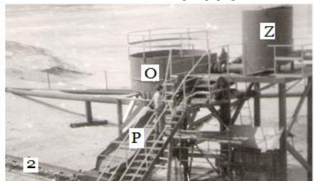
Рис. 2. Технологическая схема разделения и обезвоживания шлака. Вид объектов производящих Эльпорит: 1 – пульпа; 2 – шлак/заполнитель; 3 – угольный концентрат + микросферы; 4 – фильтрат; Z – дозирующий бак; O – центробежное сито; P – грохот; K – дробилка.
