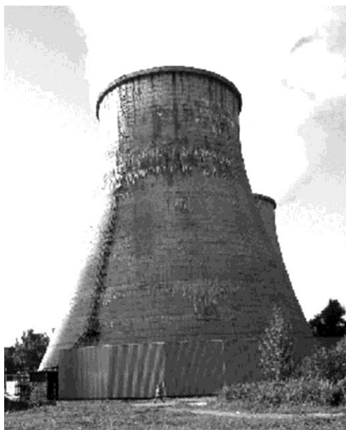
Рис. 5.78. Шумозащитный экран около градирни №2 ТЭЦ-23 ОАО «Мосэнерго»
