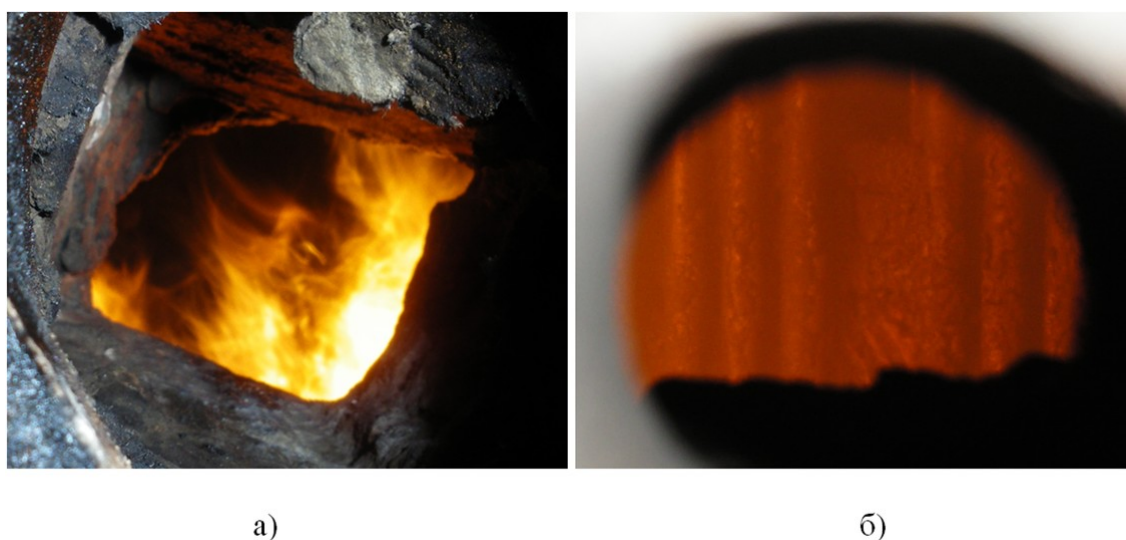
Рис. 6. Общий вид факельного сжигания нефти в топке котла ДКВР-10/12: а) горящий факел сырой нефти (вид через смотровой люк в топке котла) – исходный вариант; б) горящий факел той же самой нефти, но подготовленной к сжиганию в виде водотопливной эмульсии.
