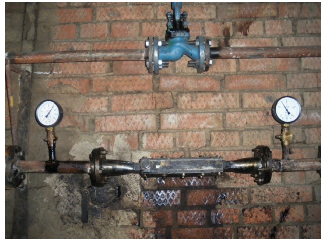
Рис.4. Общий вид устройства приготовления водонефтяной эмульсии для сжигания в топке котла
