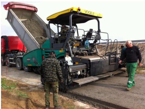
Рис. 2. Разгрузка грузовиков в асфальтоукладчик и укладка железобетонного дорожного полотна
