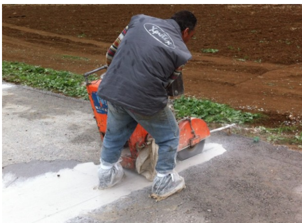
Рис. 6. Разделка стыков
