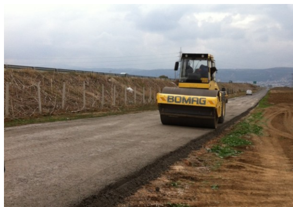
Рис. 5. Уплотнение дорожного полотна катками
