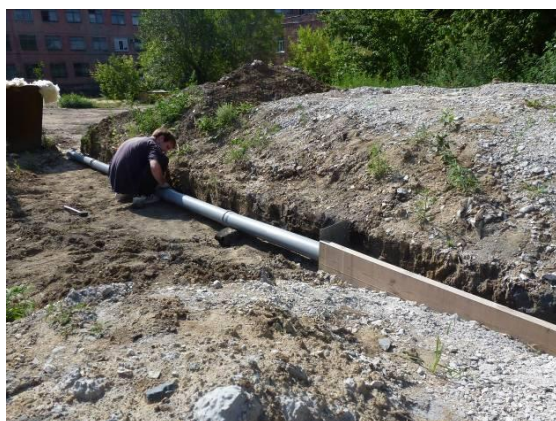
Рис. 3. Укладка геомембраны и лотка
