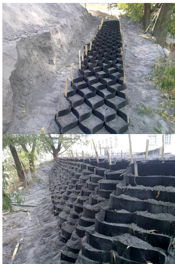
Рис. 2. Укрепление левого откоса дорожной насыпи по типу подпорной стенки.
