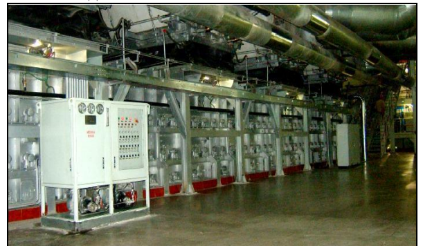
Рис. 8. Экологичная рабочая обстановка системы сухого шлакоудаления четырех блоков мощностью по 600 МВт с воздушным охлаждением.
