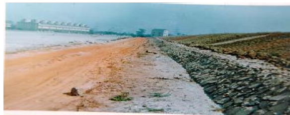
Рис. 5. Дамба, построенная с использованием летучей золы на ТЭС Кобра, Мадхя Прадеш
