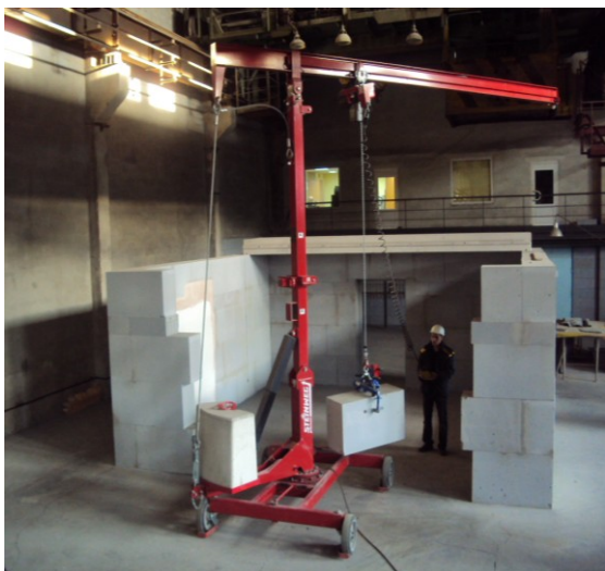
Рис. 3. Монтаж укрупненных твинблоков с помощью миникрана
