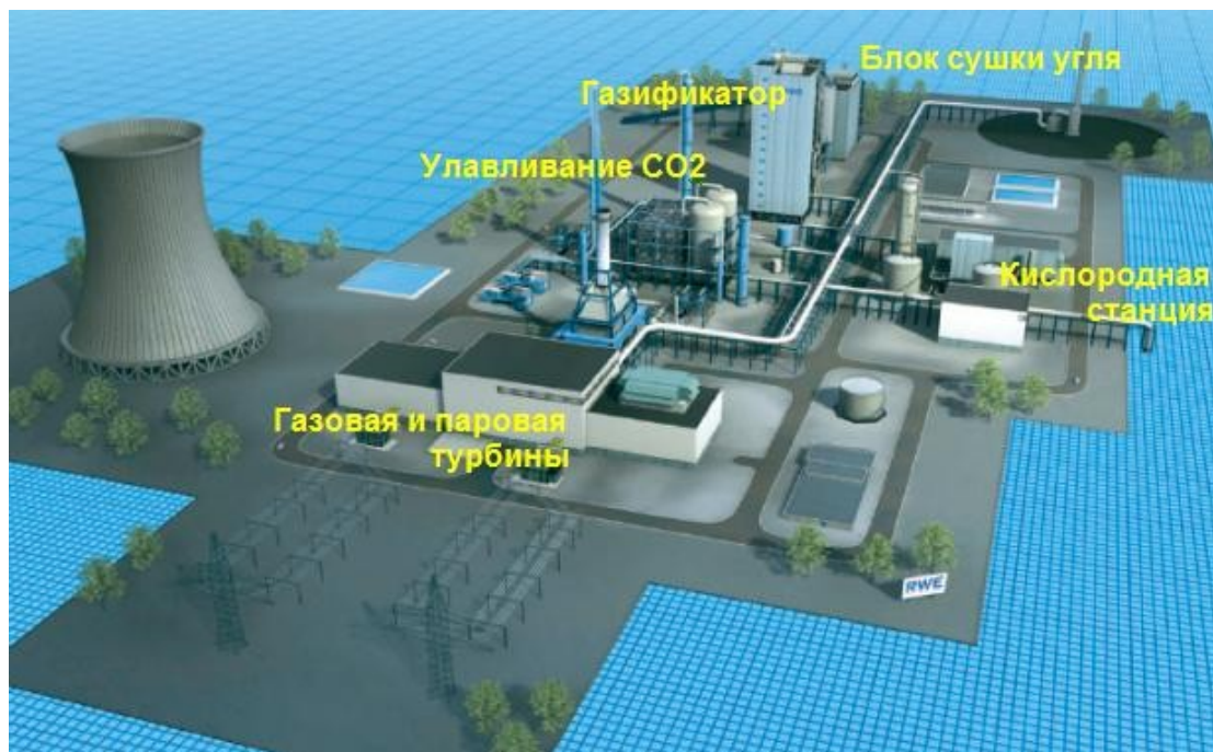
Рис. Проект RWE: ПГУ с внутрицикловой газификацией на буром угле и улавливанием CO 2 (2014 г.). Мощность блока – 450 МВт (330 МВт нетто). КПД = 35 %, включая транспорт и захоронение CO 2 . Объем улавливания CO 2 – 2,6 млн т/год. Капзатраты = €1,7 млрд (2007), включая транспорт и захоронение CO 2 .
