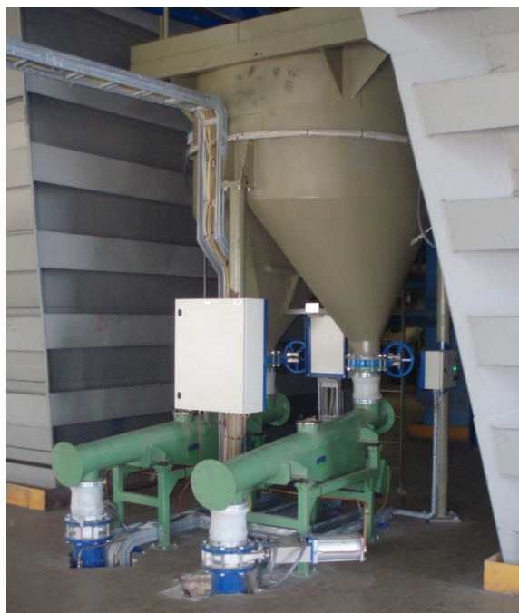
Рис. 3. Приемочный резервуар, расположенный между угольными бункерами.
