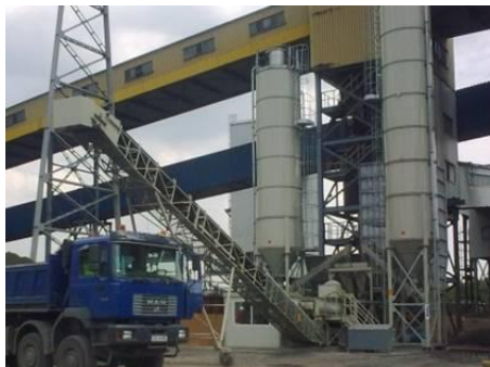
Рис. 4. Установка для производства заполнительно-вяжущих смесей на угольной шахте “Собески”.
