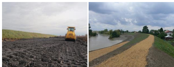
Рис. 6. Строительство дамбы на реке Висла с использованием сухой заполнительно-зольной смеси из угольной шахты „Янина”.
