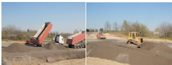
Рис. 5. Строительство окружной дороги города Хжанув с использованием заполнительно-вяжущих смесей углеобогащательного завода угольной шахты “Собески”.
