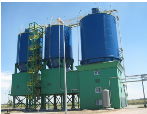
Рис. 6. Установка ST по кондиционированию летучей золы компании ZGP
