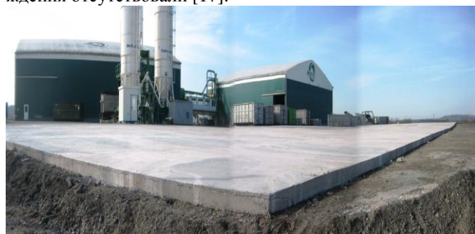
Рис. 3. Забетонированная базовая плита, произведенная с использованием СЕМ II ВМ (W-LL) - MUEG [17].
